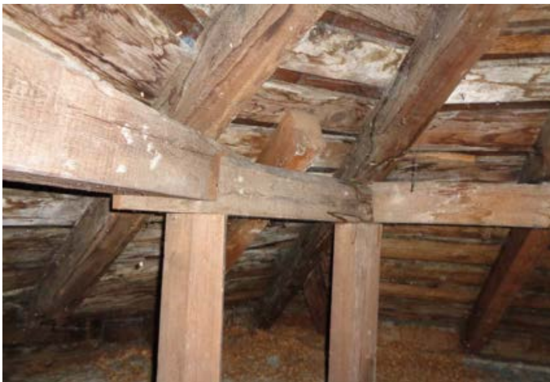
Fot. 25. Dach E – widoczne zawilgocenia deskowania
