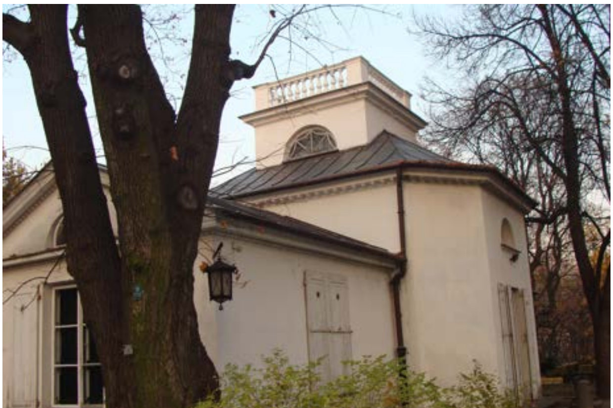
Fot. 8. Elewacja południowa
