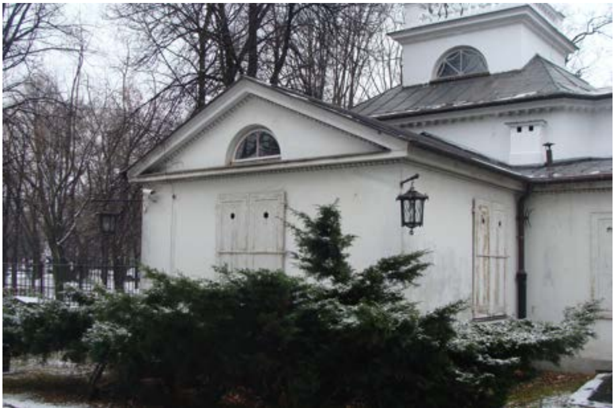
Fot. 7. Ryzalit elewacji wschodniej, ogrodowej
