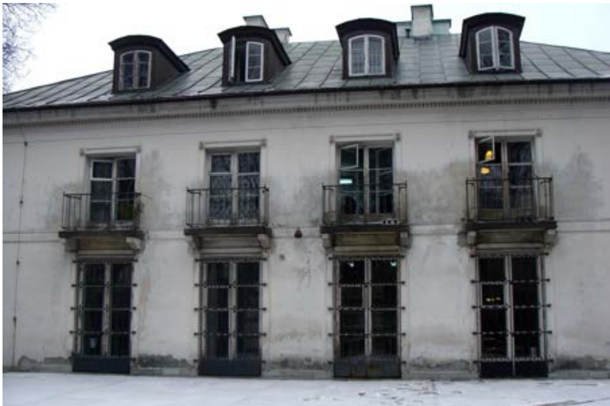
Fot. 5. Elewacja północna, boczna – część dwukondygnacyjna
