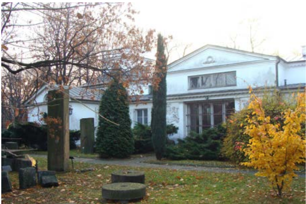
Fot. 6. Elewacja wschodnia, ogrodowa
