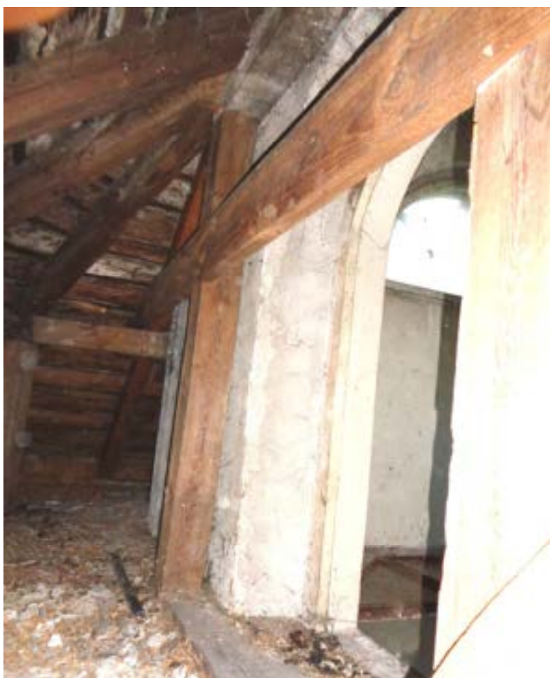
Fot. 25. Dach E – widoczne zawilgocenia deskowania
