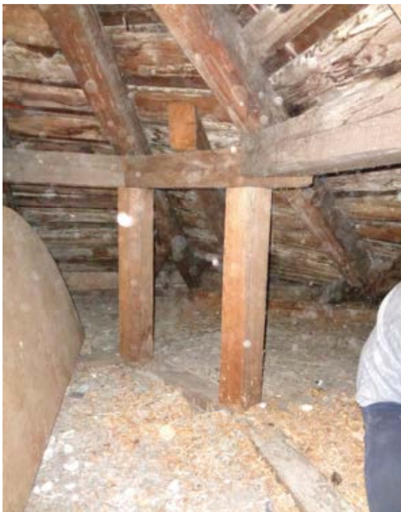
Fot. 23 i 24.. Dach E – widoczne zawilgocenia deskowania
