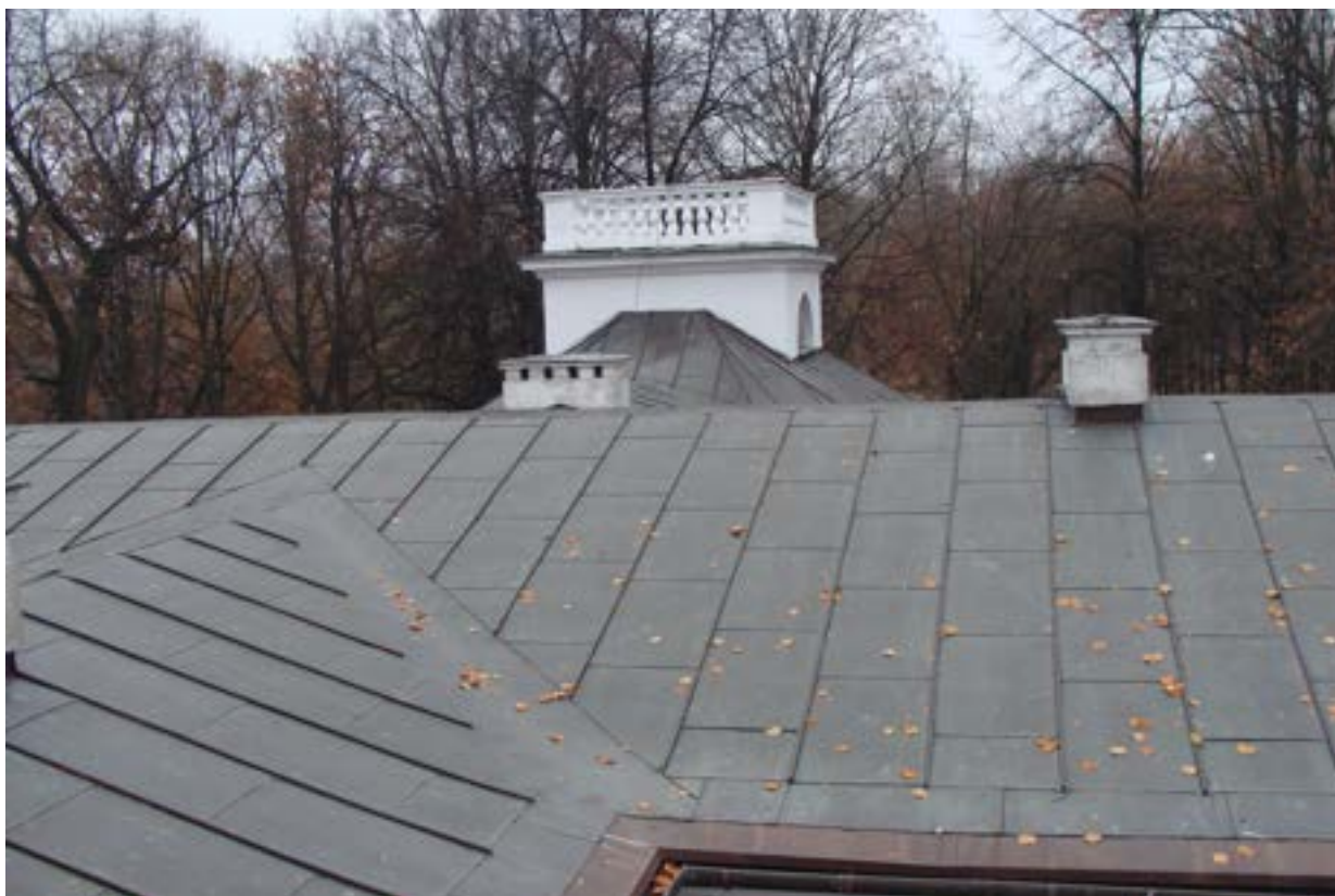
Fot. 9. Widok dachu w kierunku południowym
