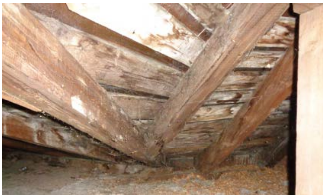
Fot. 18. Połączenie dachów D i E
