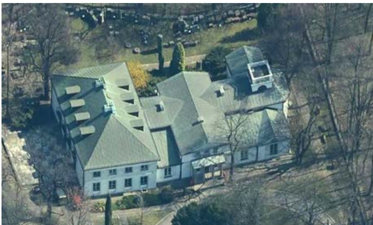
Fot. 2. Widok dachów obiektu, stan aktualny
