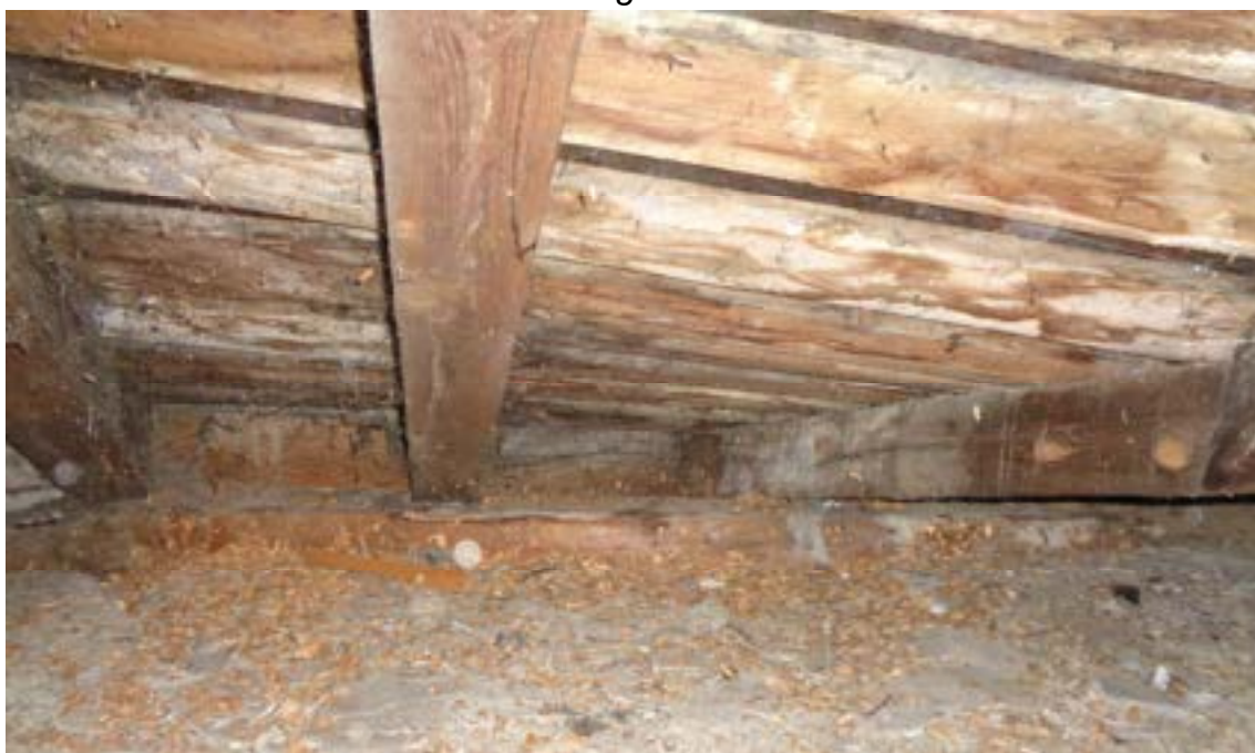
Fot. 23 i 24.. Dach E – widoczne zawilgocenia deskowania
