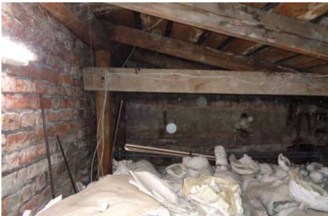
Fot. 27 i 28. Dach G – zawilgocenia deskowania i krokwi
