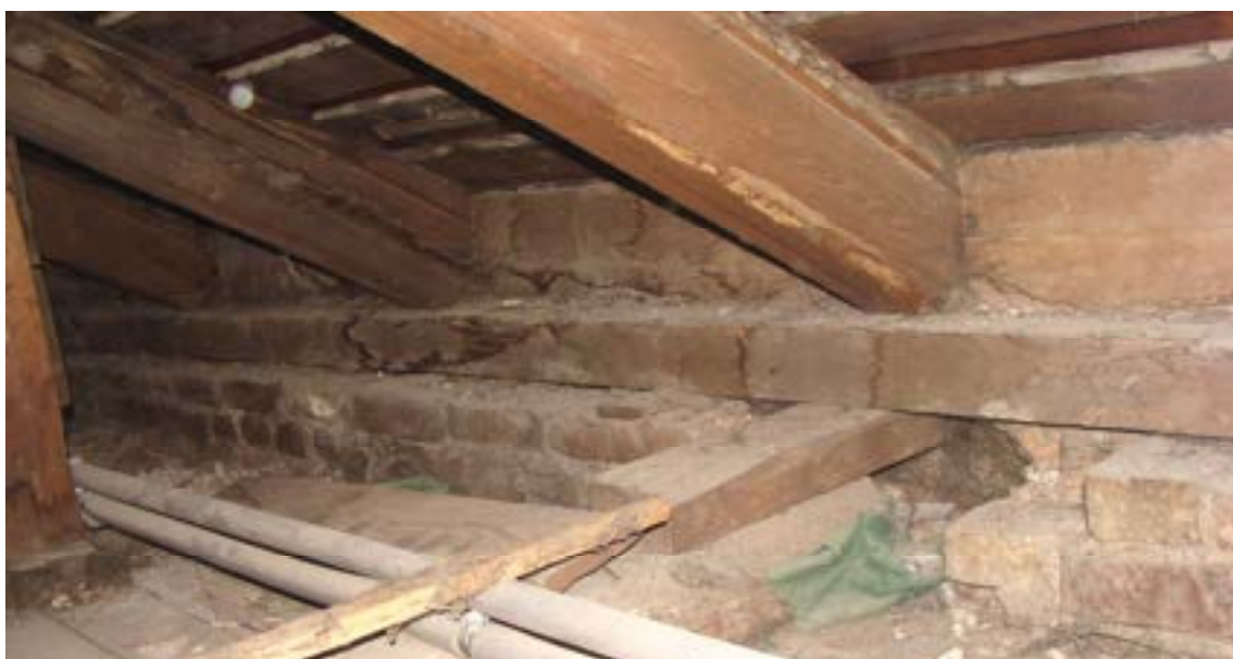
Fot. 15. Fragment więźby – część dolna
