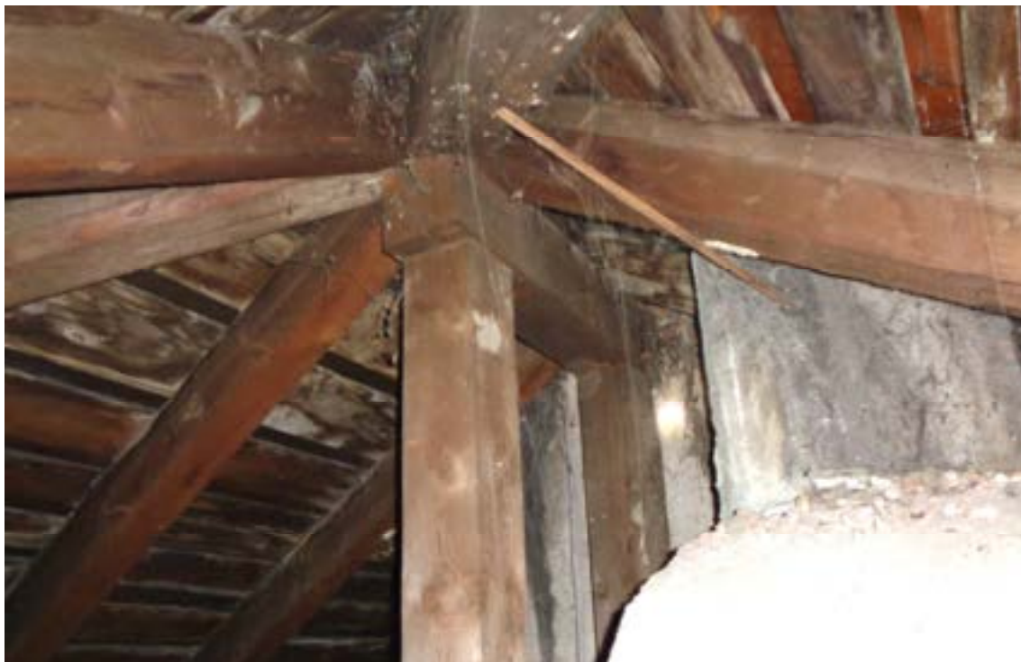
Fot. 17. Fragment więźby – widoczna płatek kalenicowa i zawilgocenia deskowania
