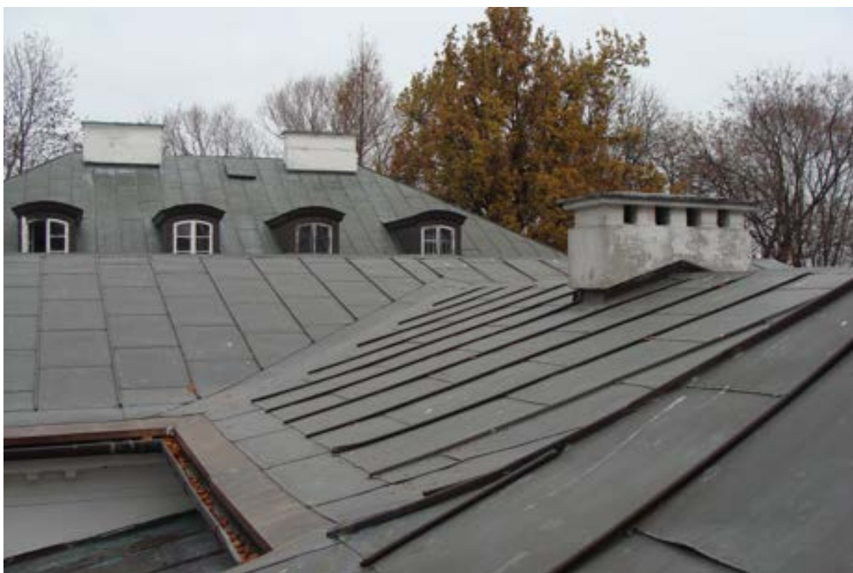
Fot. 10. Widok dachów w kierunku północnym
